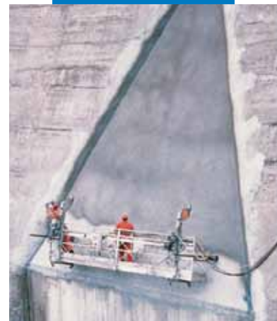
Нанесение Mapelastic на дамбу распылением
